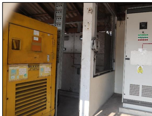
รูปที่ 2-34 เครื่องกำเนิดไฟฟ้าสำรอง
