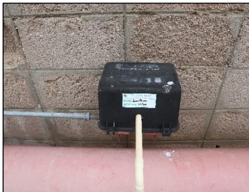
รูปที่ 2-11 ปัมสำหรับต่อเครื่องเป่าอากาศในบ่อบำบัด เพื่ออัตราการลอยตัวของอากาศ
