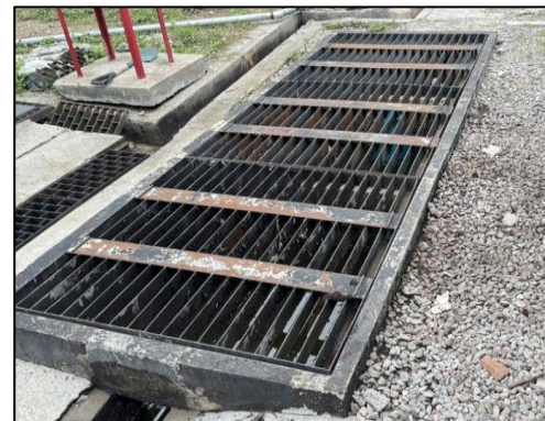
รูปที่ 2-12 บ่อ API ที่บริเวณโรงจ่ายน้ำมัน
